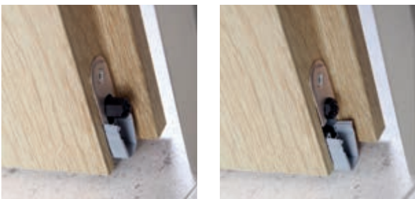
Standardausstattung bei Schallschutztüren: mechanisch absenk- bare Bodendichtung
