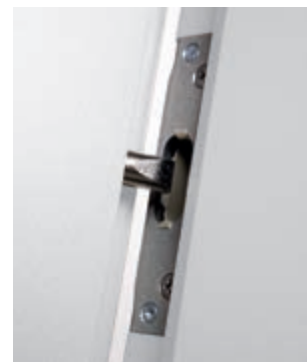
Auf Nummer sicher: Eine Dreipunkt-Verriegelung macht es Einbrechern schwer.
